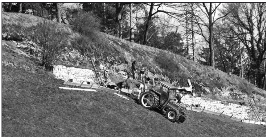
Bereits nach einer Woche ist ein Grossteil der Mauer wieder aufgebaut.
